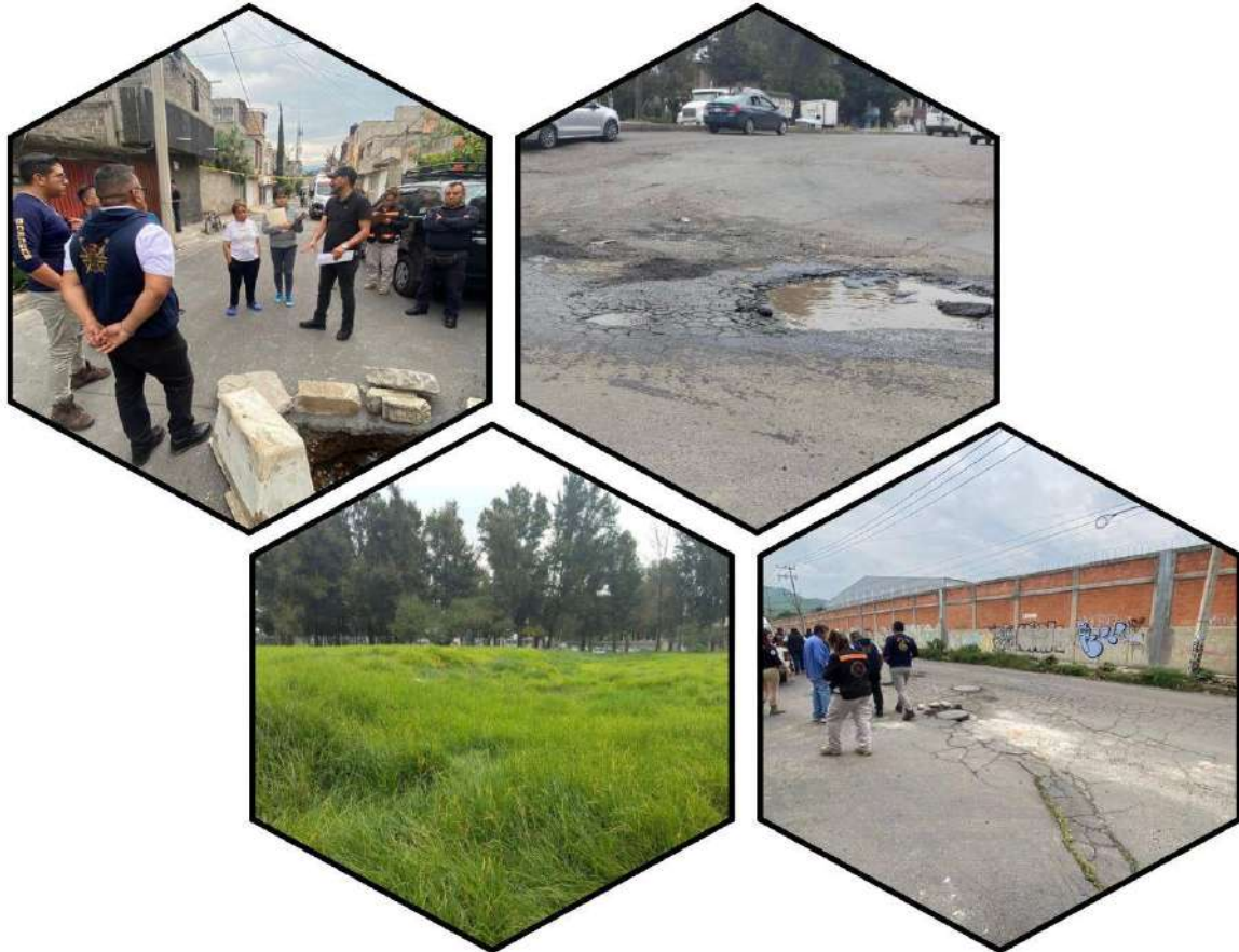
Fotografía 4. Colonia Santa Catarina. Municipio de Valle de Chalco Solidaridad. Fuente: Protección Civil y Heroico Cuerpo de Bomberos Valle de Chalco Solidaridad.
