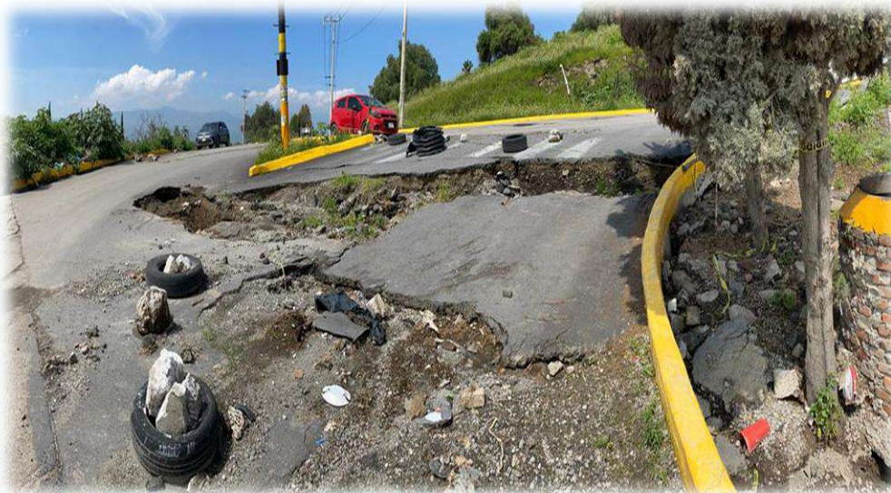
Fotografía 1: Avenida Real de San Martín, Cerro del Márquez, Valle de Chalco Solidaridad 2025. Fuente: Protección Civil y Heroico Cuerpo de Bomberos Valle de Chalco Solidaridad.
