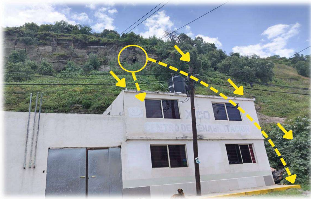
Fotografía 3. Calle Pirul, entre López Mateos y Tepozán, en la Colonia San Martín Xico de Laguna. Valle de Chalco Solidaridad Fuente: Protección Civil y Heroico Cuerpo de Bomberos Valle de Chalco Solidaridad.
