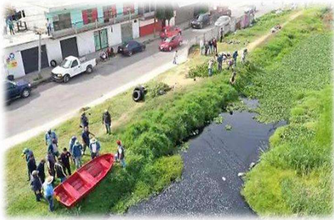
Fotografía 1: Canal Acapol Valle de Chalco Solidaridad Fuente: Protección Civil y Heroico Cuerpo de Bomberos Valle de Chalco Solidaridad
