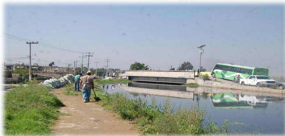
Fotografía 3: Canal Acapol Valle de Chalco Solidaridad Fuente: Protección Civil y Heroico Cuerpo de Bomberos Valle de Chalco Solidaridad
