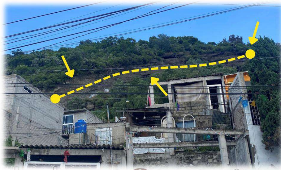
Fotografía 2. Valle de Chalco Solidaridad. Avenida López Mateos San Miguel Xico. Fuente: Protección Civil y Heroico Cuerpo de Bomberos Valle de Chalco
